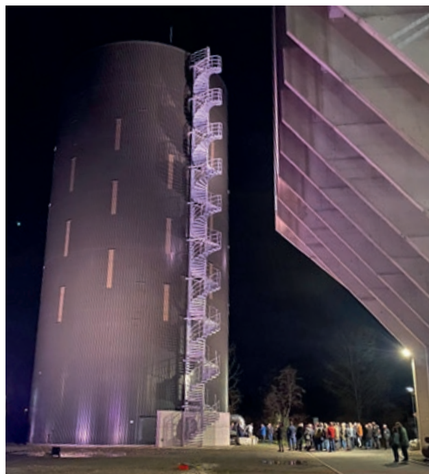
Einweihungsfeier Heisswasserdruckspeicher 24. November 2022.
