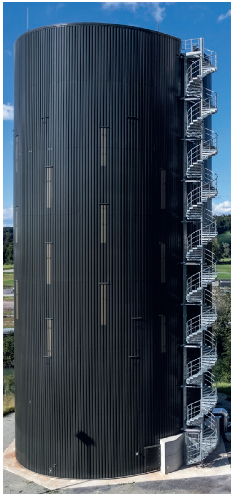
Blick auf den Heisswasserdruckspeicher und den LUKO.
