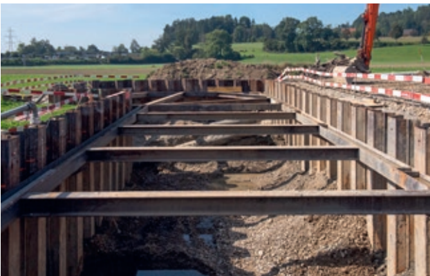
Rohrleitungsbau Fernwärme Ennetsee
